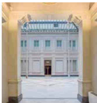
Le Reali Poste dopo il restauro.
